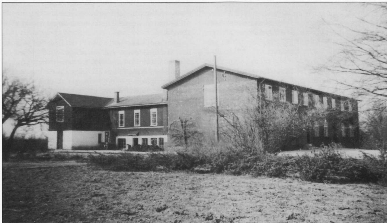
Skolen i den nye skikkelse efter ombygningen 1940.
